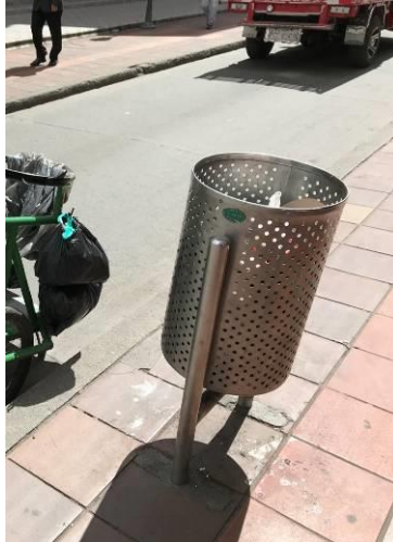
Foto 40. Cestas instaladas en Cali
