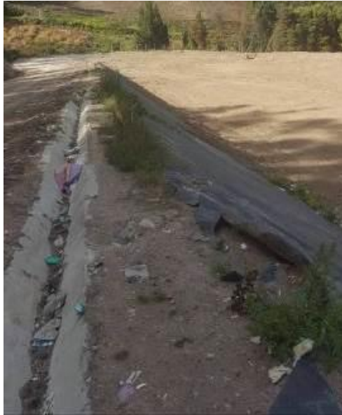
Foto 64. Canales en concreto
