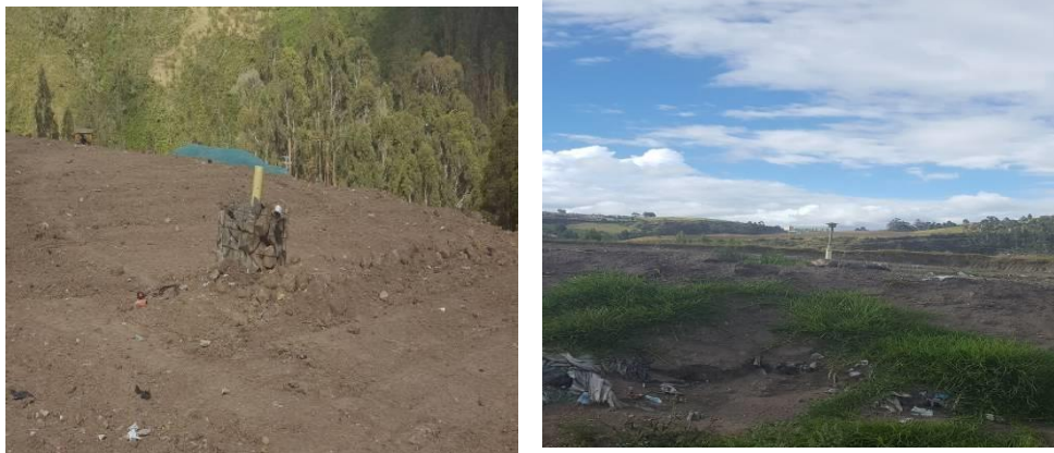
Foto 66 y 67 Chimeneas de extracción de gases
