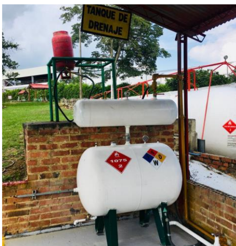
Figura 6. Sistema de drenaje INTERGAS S.A. E.S.P.
