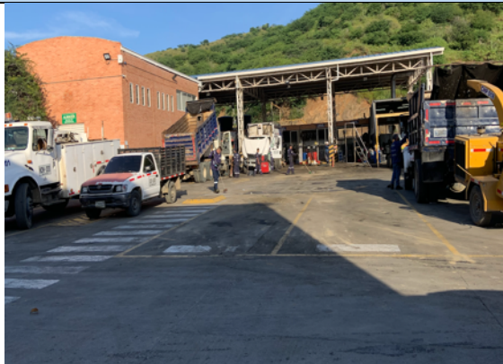
Zona de parqueo de vehículos compactadores
