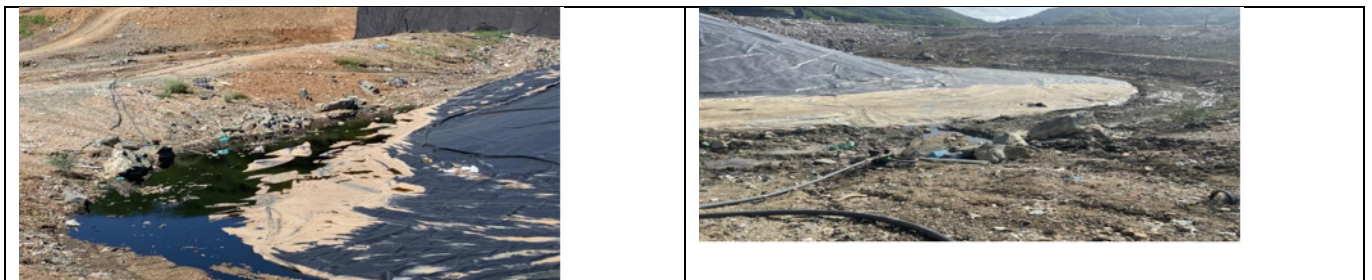
Imagen 28. Registro fotográfico empozamiento de lixiviados
