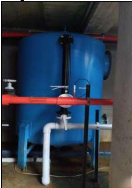
Se pudo observar, que la PTAP cuenta con dos módulos de filtración descendente y dos módulos de filtración de carbón activado, los cuales funcionan en paralelo.
