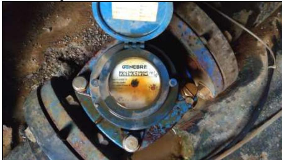
**Imagen 25. Macromedidor a la salida de los tanques de filtración**
