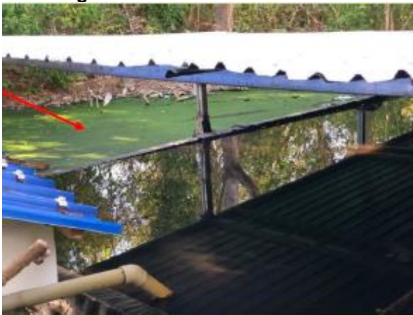
Imagen 27. Rebosamiento del lixiviado
