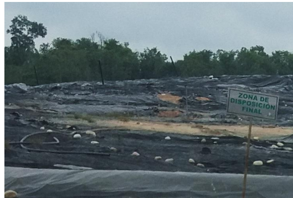
Figura N° 21. Chimeneas que perdieron posición vertical.
