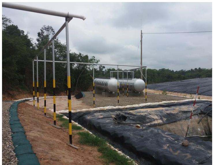
Tanques horizontales de 10000 galones
