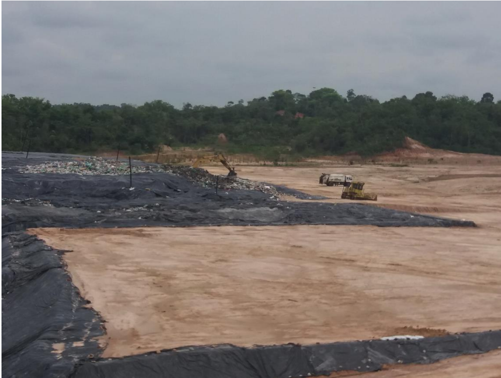
Figura N° 10. Disposición de residuos sólidos. Celda 1, subcelda 7.
