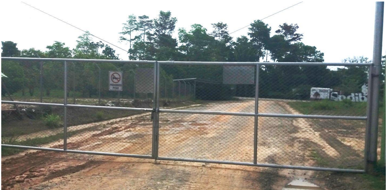
Figura N° 7. Cerramiento del relleno sanitario – Reja - Malla electrosoldada
