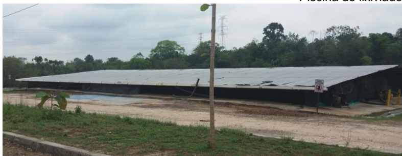
Piscina principal de almacenamiento de lixiviados
