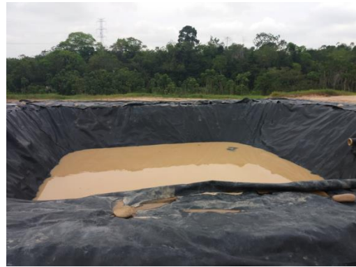
Piscina de agua lluvia
