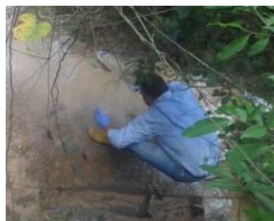
Margen izquierdo - Boxculvert
