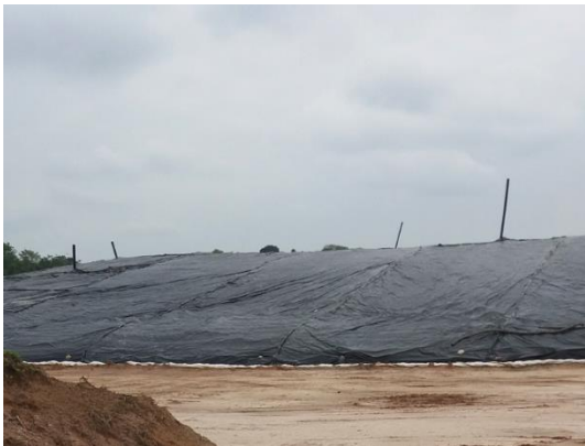
Figura N° 21. Chimeneas que perdieron posición vertical.
