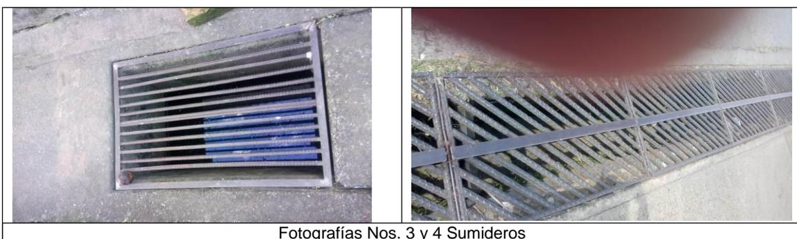
**Mantenimiento de redes:** En la visita efectuada por la Superservicios, el prestador informó que se adelanta como mantenimiento preventivo la limpieza de los sumideros los cuales se conectan con los pozos de inspección, según se indicó la actividad se efectúa una o dos veces al mes y el correctivo se programa de manera inmediata, se lleva bitácora de operación y registro fotográfico de la actividad.
