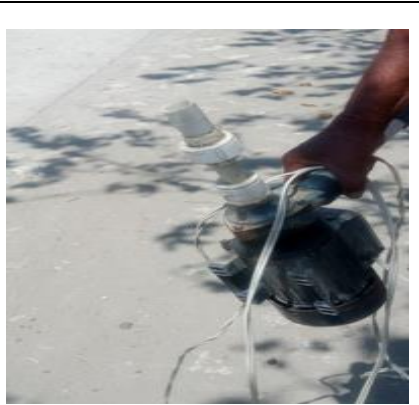
Fotografía No. 15 Bombas de bajo caudal instaladas en viviendas
