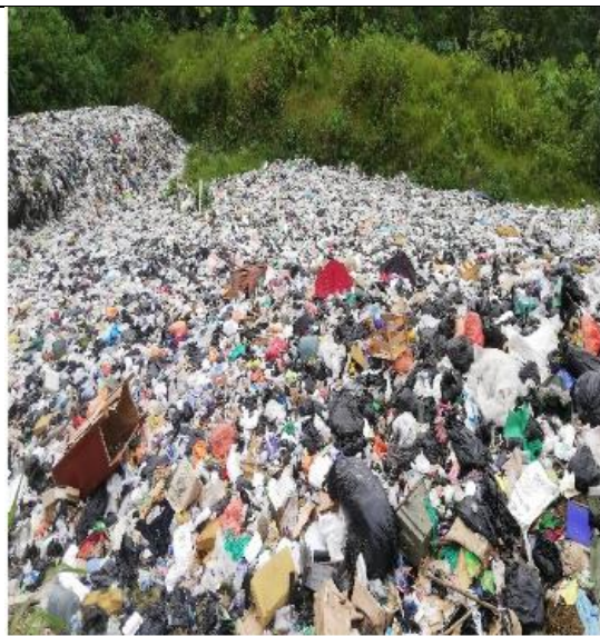
Se evidencia residuos sin cobertura ni compactación
